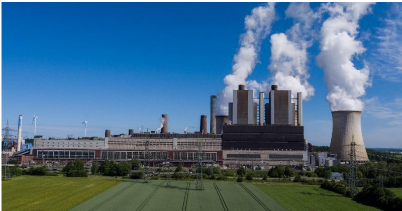
Abbildung 4: Kraftwerk Weisweiler (Quelle: Luftbildschrägaufnahme Opterix)
